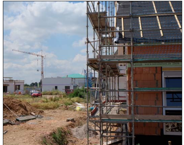
Stillstand auf der Baustelle. Im vergangenen Jahr sind die Neuanträge für Baufinanzierungen um 43 Prozent gegenüber 2021 gesunken.
